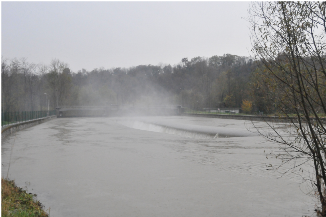
Figura 22 - Scolmatore di San Mauro sul fiume Corno in funzione
