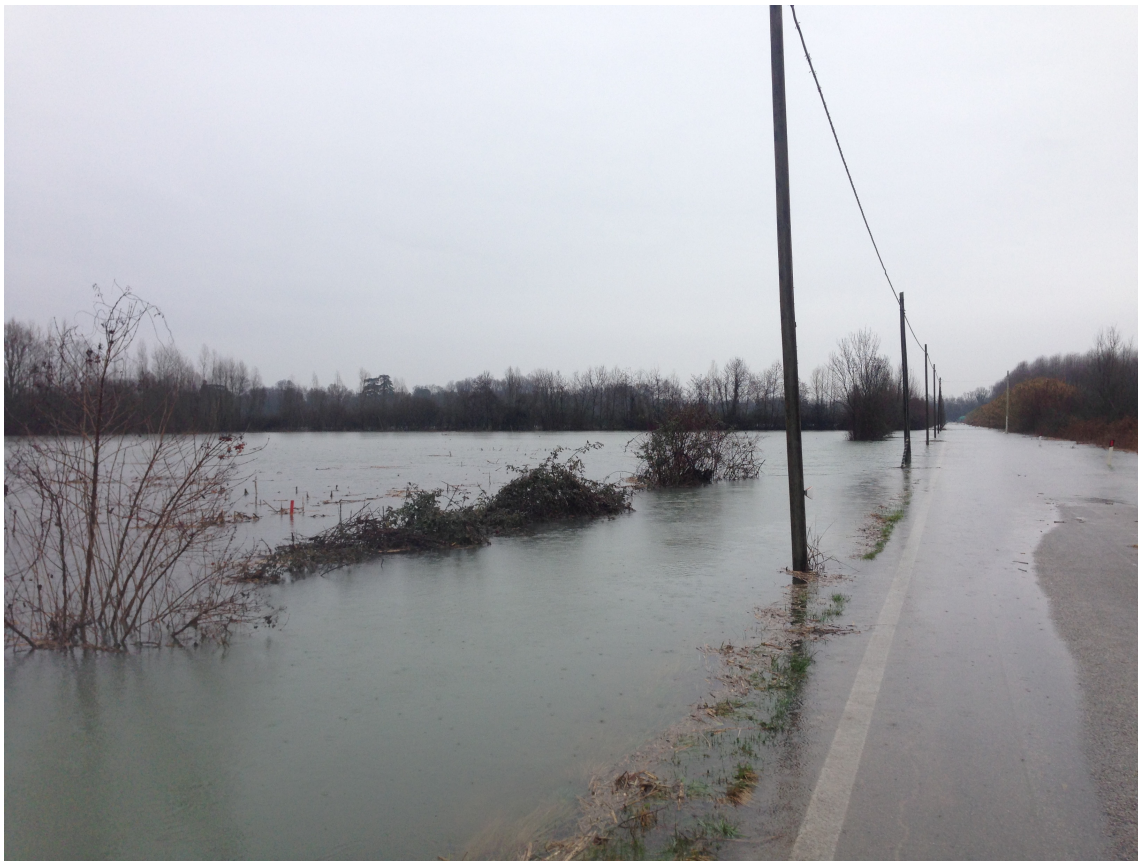
Figura 25 - Allagamenti presso Ariis - Rivignano
