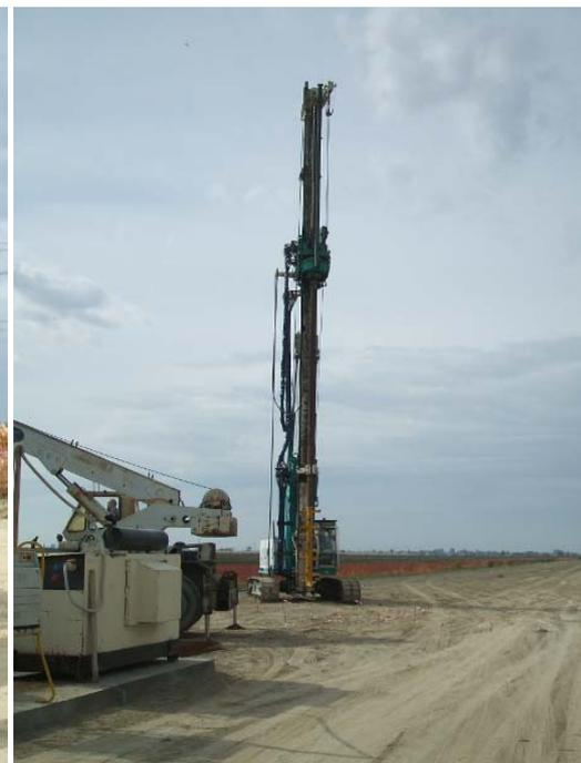
Realizzazione dell'intervento di consolidamento del sottofondo dei rilevati con la tecnica del deep mixing a cemento
