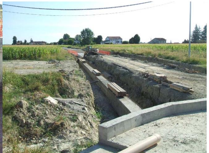
Realizzazione dell'intervento di consolidamento del sottofondo dei rilevati con la tecnica del deep mixing a cemento
