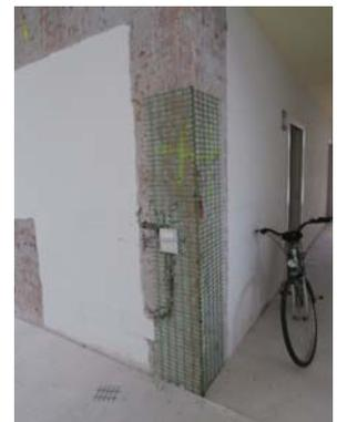
Rimozione dell'intonaco e posa della rete in FRP
