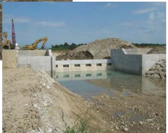
Immagini dell'opera durante le fasi di realizzazione del canale fugatore e di costruzione del nuovo salto di fondo
