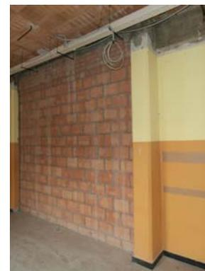
Incrocio nuova muratura sismoresistente con pilastro
