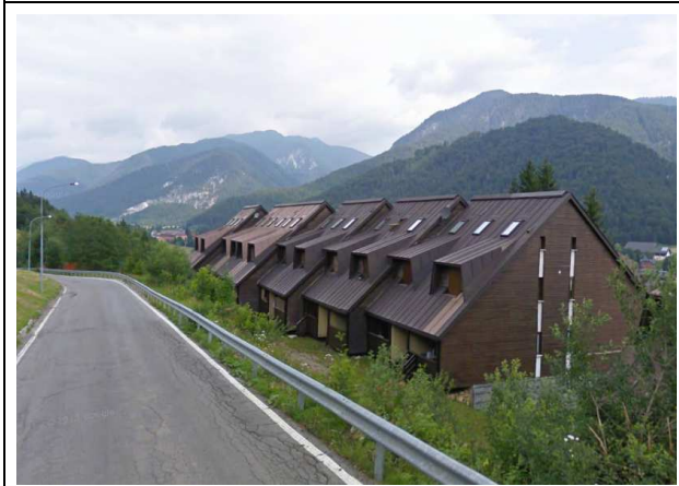
2. Vista degli edifici residenziali lungo Via Priesnig
