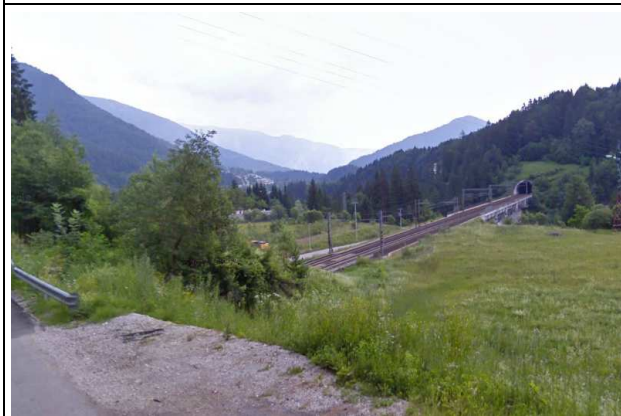
4. Vista lungo la linea ferroviaria
